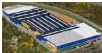
Hörmann KG Eckelhausen, Allemagne
