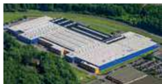
Hörmann KG Eckelhausen, Allemagne
